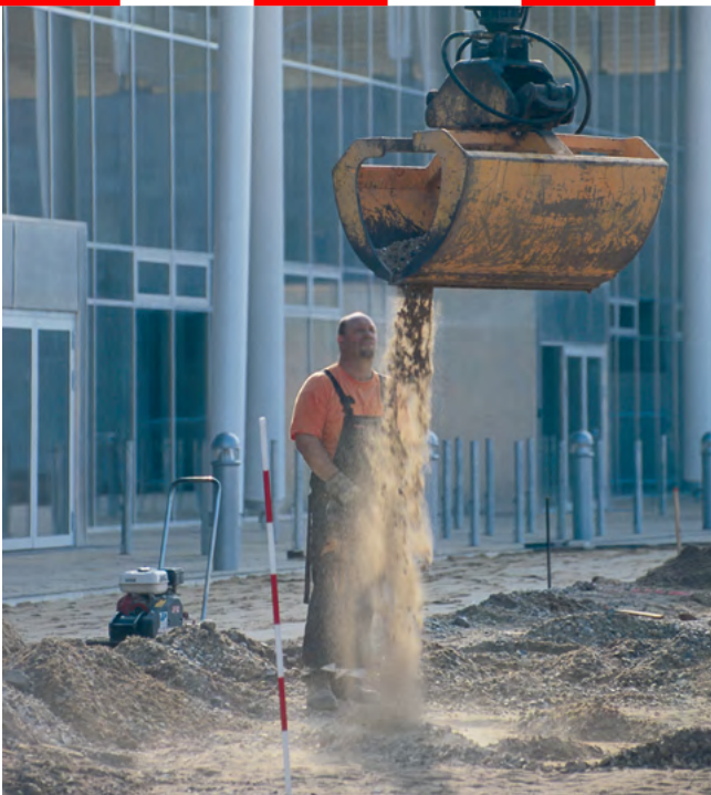
Værnemidlerne mangler og han er for tæt på maskinens bevægelige dele = ulykkesrisiko
